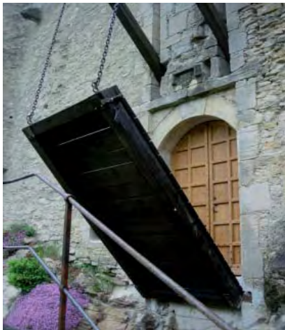
Vue générale et détail du pont-levis restitué du château de Vertrieu (Isère)
