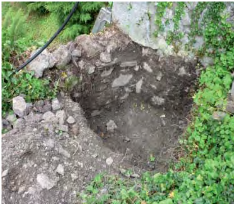
Le sondage réalisé sur le dessus de la galerie.
