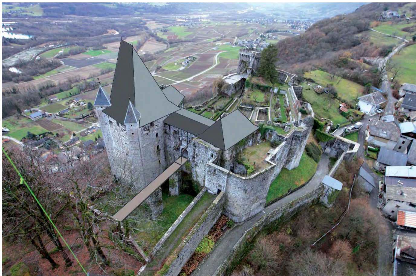
Restauration des toitures de la partie centrale du château:: solution variante (toitures ardoises sur la salle des gardes)
