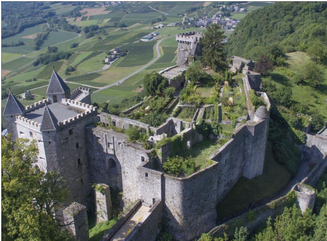
Accroché au flanc sud de l'Arclusaz, le château de Miolans rouvrira ses portes au public le samedi 1 er avril.
